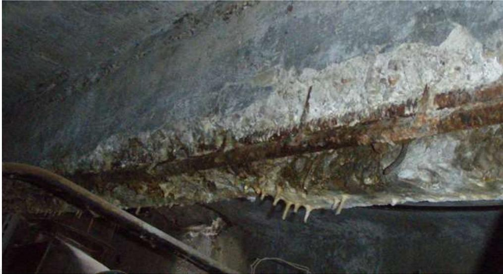
Коррозия бетона поперечной балки с оголением и коррозией рабочей арматуры (5%)
