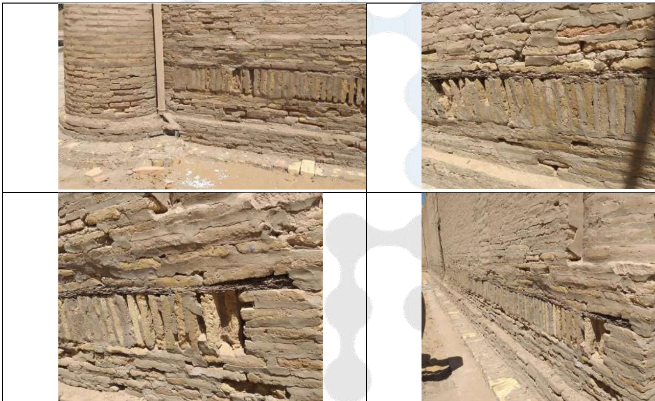
7-расм. Бинонинг цокол қисмида қамиш қатлампидан сейсмик ва гидро ҳимоя қаталми сифатида фойдаланиш.
